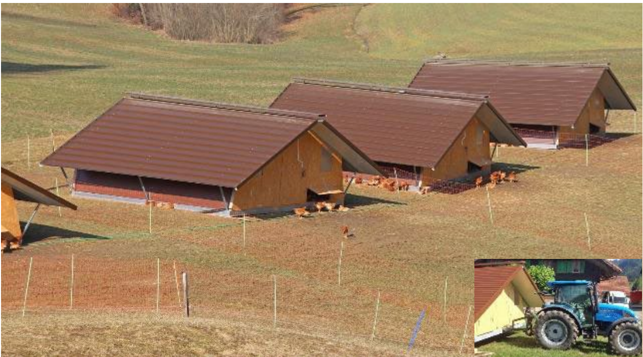
Abbildung 2: Beispiele von mobilen Geflügelställen; oben: Legehennen (Quelle: https://farmermobil.com/de/mobilstaelle/ ); unten: Mastpoulets inkl. Verschieben der Ställe. Quelle: https://in-auen.ch/produkte/gefluegel/bio-mobi-pouletmast/ ).
